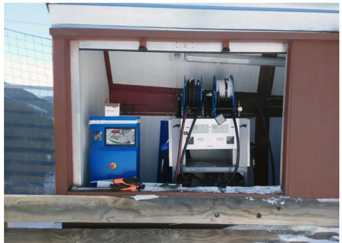
La tubería KPS conecta el tanque aéreo con los elementos de repostaje situados en el exterior.
