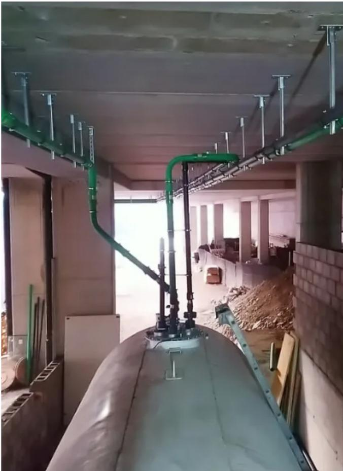
Tanques aéreos de gasóleo: La tubería KPS se instaló en el techo de la galería sobre unos soportes metálicos
