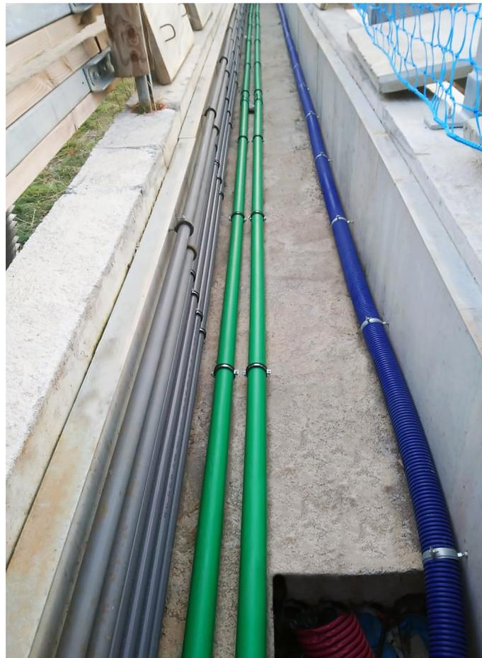
Se instalaron rollos de tubería de doble pared KP 75/63 en un foso alrededor de la estación de esquí
