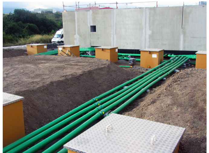
La tubería conductiva de KPS es electrostáticamente segura, evitando la posible acumulación de electricidad estática
