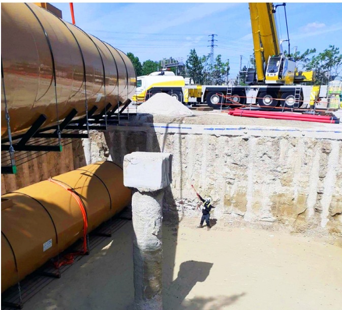
Se instaló tubería KPS conductiva de 4" (125/110 mm) para conectar el punto de llenado remoto con los tanques de combustible
