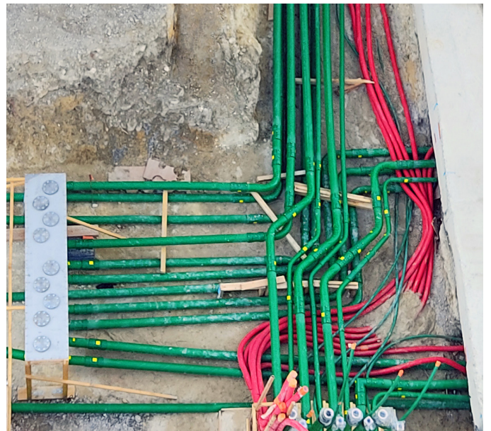
La tubería conductora KPS evita la acumulación de electricidad estática en el sistema.
