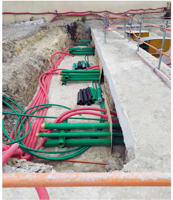
La tubería KPS está libre de corrosión
