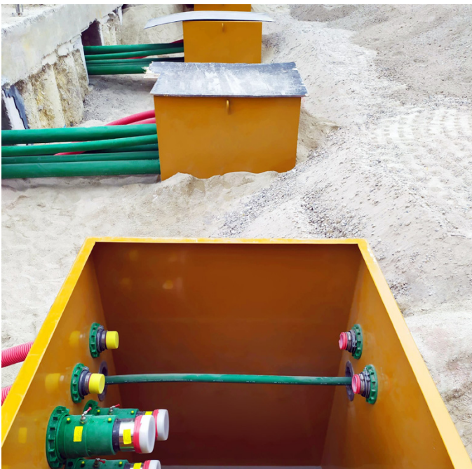
La tubería KPS de 4" permite un caudal de 933 litros / minuto, lo que permite un suministro rápido de combustible
