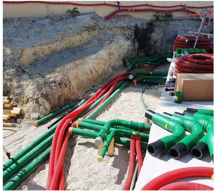
Las tuberías de doble pared de KPS crean un espacio intersticial entre las tuberías internas y externas, lo que añade una capa adicional de seguridad.
