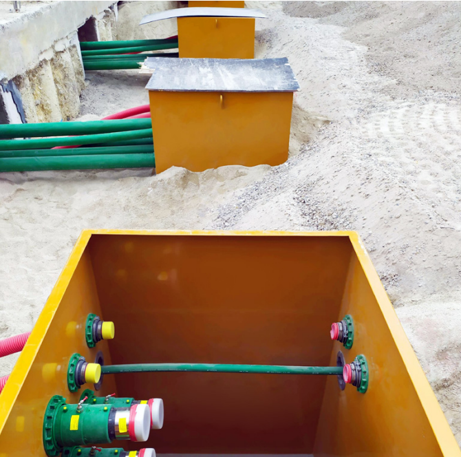
KPS 4" boru sistemi, 933 litre/dakika akış hızı sağlar.
