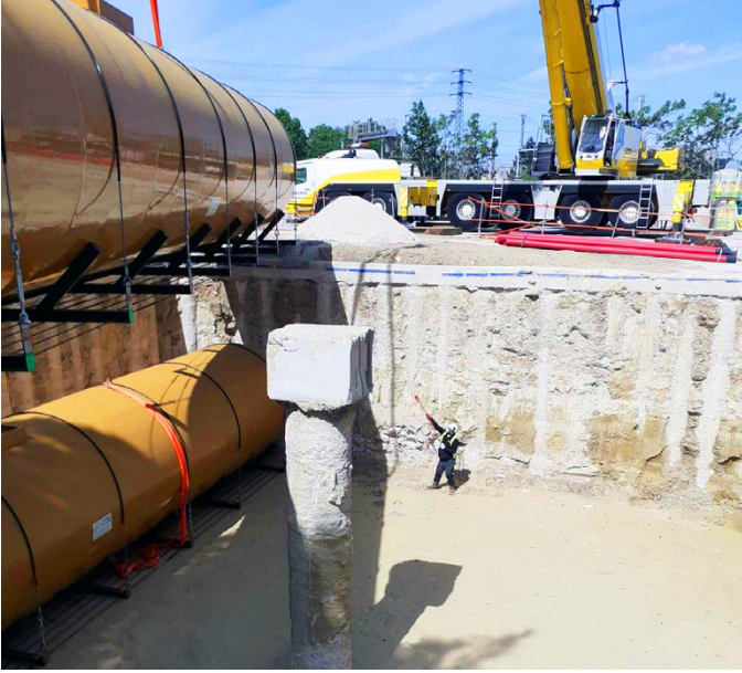
Uzak dolum noktasının yakıt depolarına bağlanması için KPS iletken 4" boru (125/110mm) kullanıldı.
