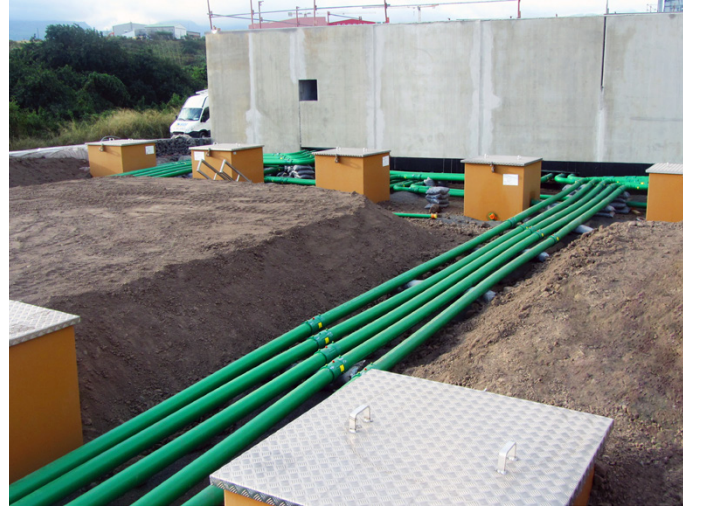
KPS'nin iletken boruları, potansiyel statik birikimi önler elektrostatik olarak güvenlidir
