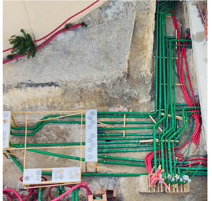
Uzak dolum noktalarını ve yer altı yakıt tanklarını bağlamak için KPS' 4" (125/110mm) çift cidarlı boru tesisatı kuruldu.
