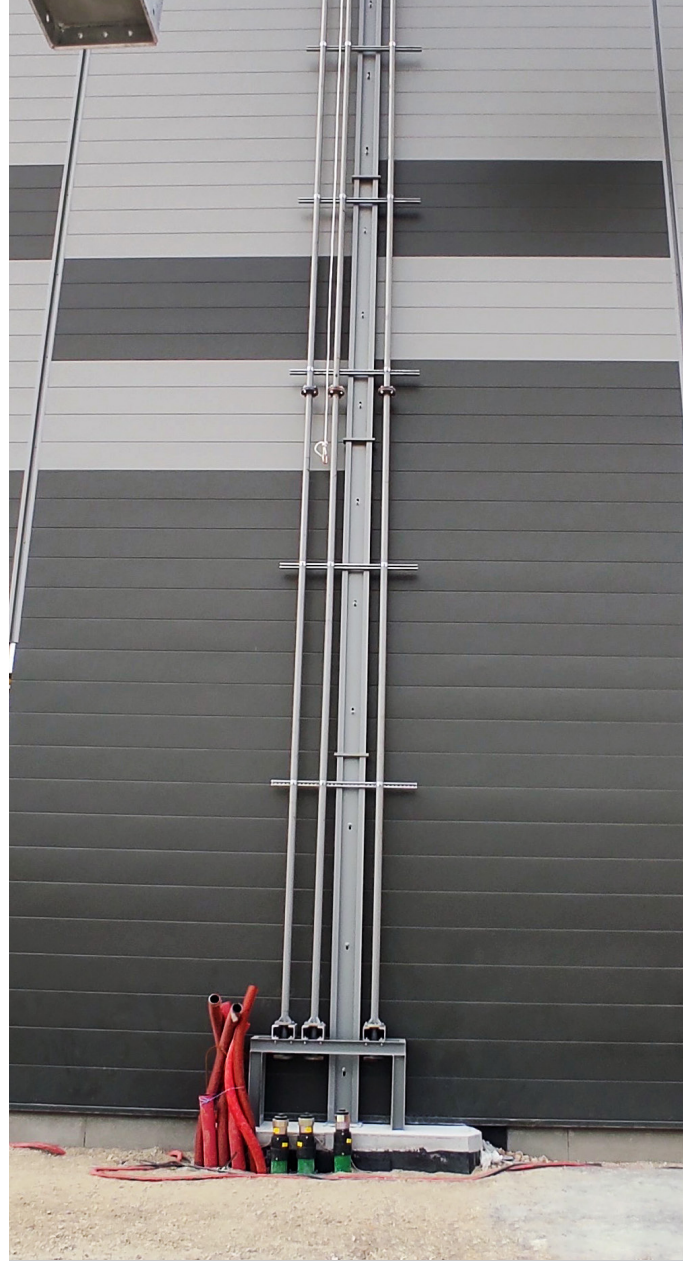
Yakıt tanklarını tesisin dış duvarından geçen metal borulara bağlamak için KPS' 2" (75/63mm) çift cidarlı boru tesisatı kuruldu.
