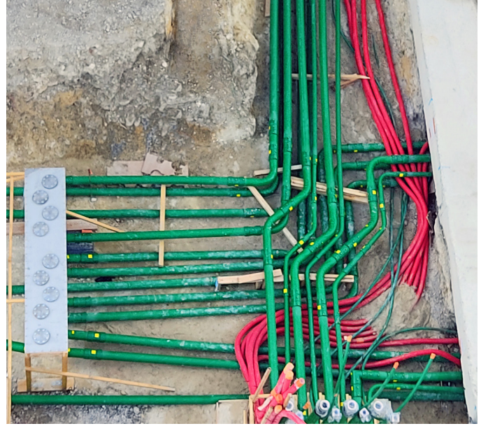
İletken KPS boruları elektrostatik olarak güvenlidir ve potansiyel static elektrik birikimi önler.
