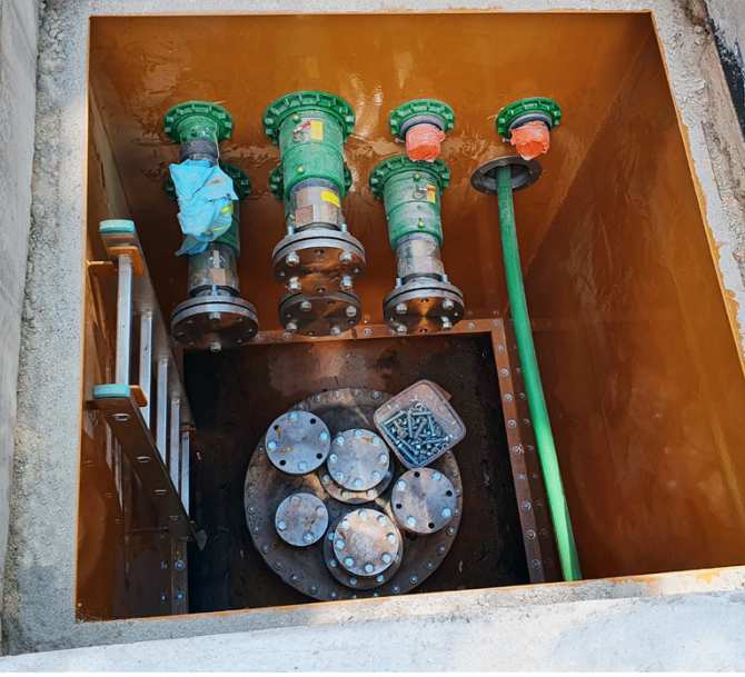
KPS, giriş botları da dahil olmak üzere tam anlamıyla sıvı geçirmez bir çözüm sağladı.
