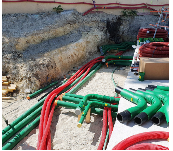
KPS'nin çift cidarlı boru sistemi, iç ve dış borular arasında ekstra bir güvenlik katmanı sağlayan bir ara boşluk içerir.
