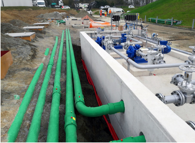
KPS iletken çift cidarlı borular, Etanol'ün statik elektrik oluşturma potansiyeli için mümkün olan en yüksek güvenlik seviyesini sağlar
