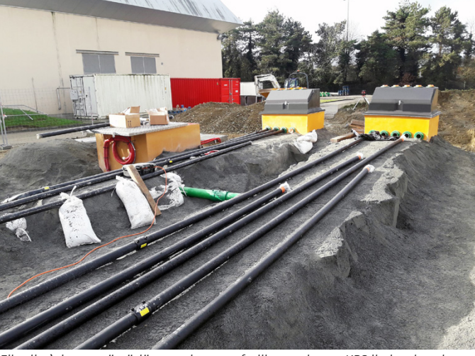
Fibrelite'nin uzun ömürlü su geçirmez nefeslik sumpları ve KPS iletken boruları
