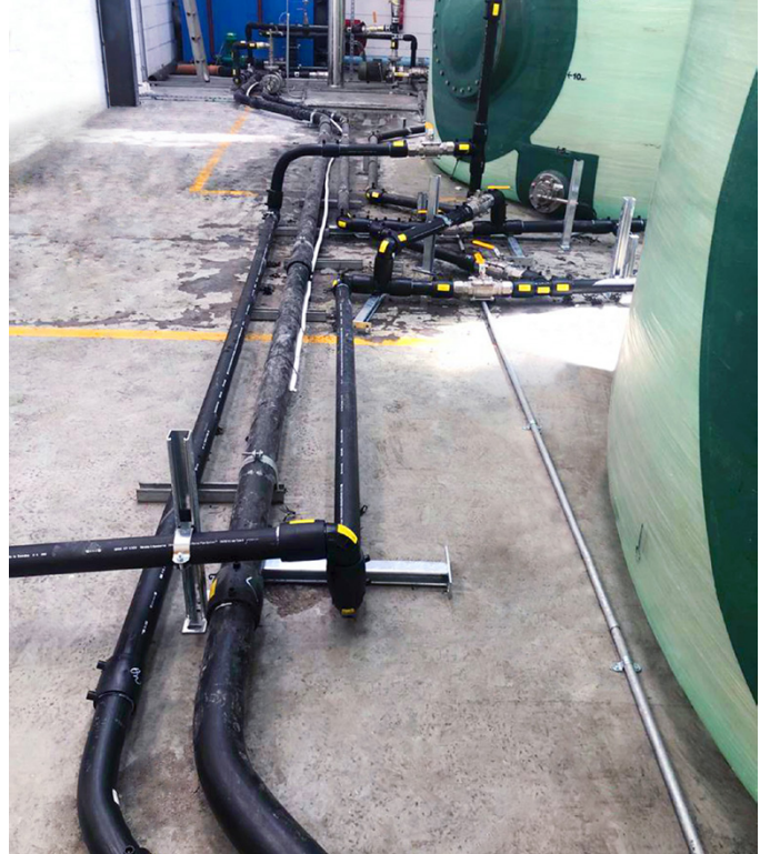
KPS boru sistemi tesisatçılar için tasarlanmıştır, maliyeti ve montaj süresini azaltır
