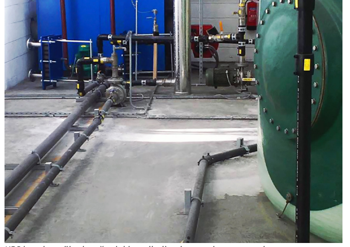
KPS boruları yüksek yoğunluklu polietilenden yapılmıştır ve yakıtın sızmasını önlemek için kaplamalar içerir
