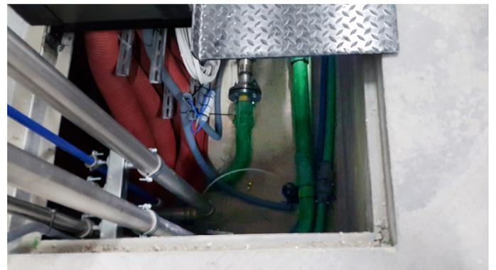
Les tuyaux KPS permettent le passage d'un débit élevé, ici 933l/min
