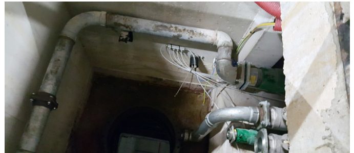
El sistema de detección de fugas KPS permite monitorear el espacio intersticial entre las tuberías interna y externas.
