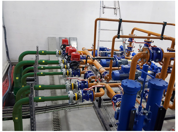
La tubería conductiva de KPS es electrostáticamente segura y evita la acumulación de carga estática.
